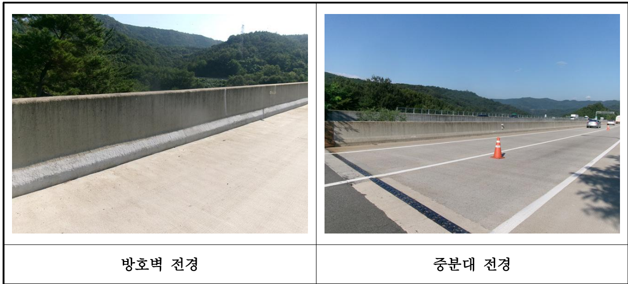
【사진 13.3.24】 방호벽 및 중앙분리대 전경
