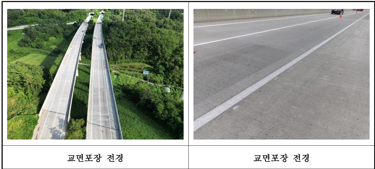
【사진 13.3.45】 교면포장 전경
