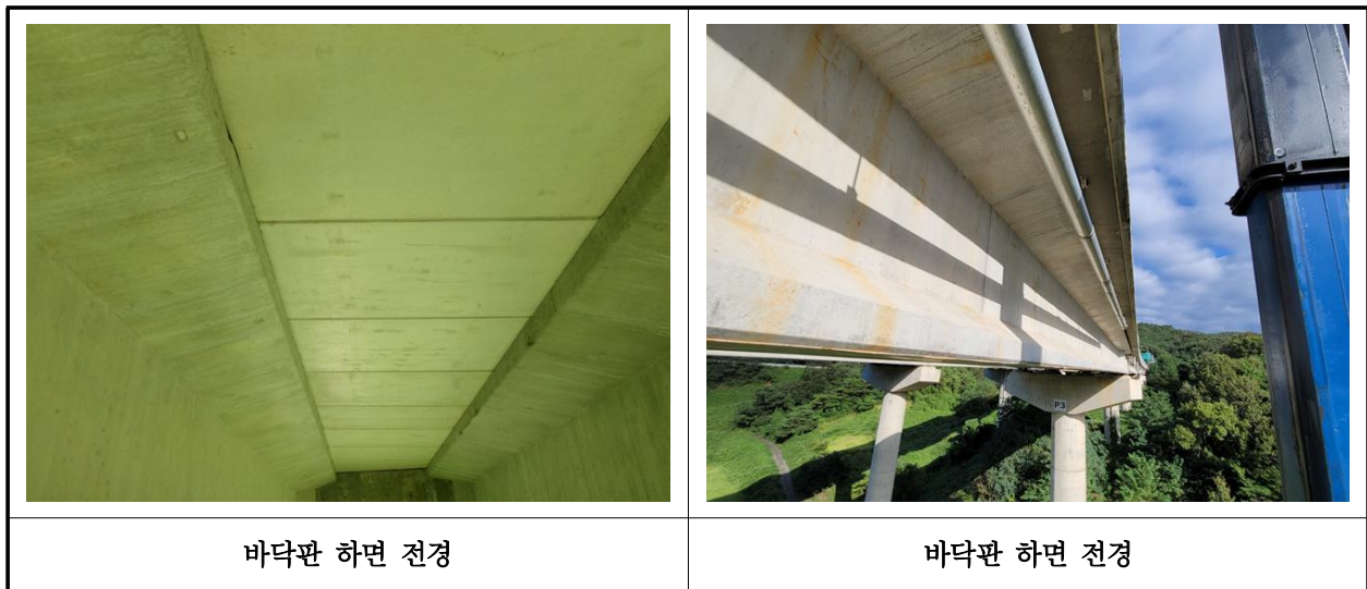
【사진 13.3.27】 바닥판하면 전경
