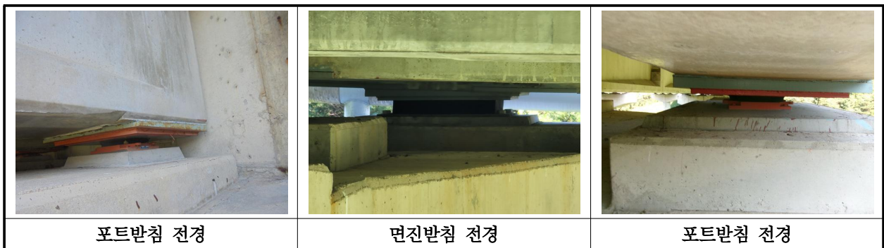
【사진 13.3.13】 교량받침 전경
