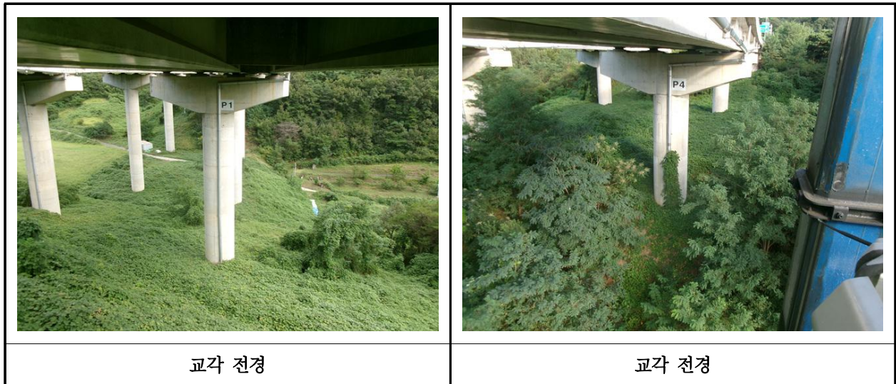
【사진 13.3.35】 교각 전경
