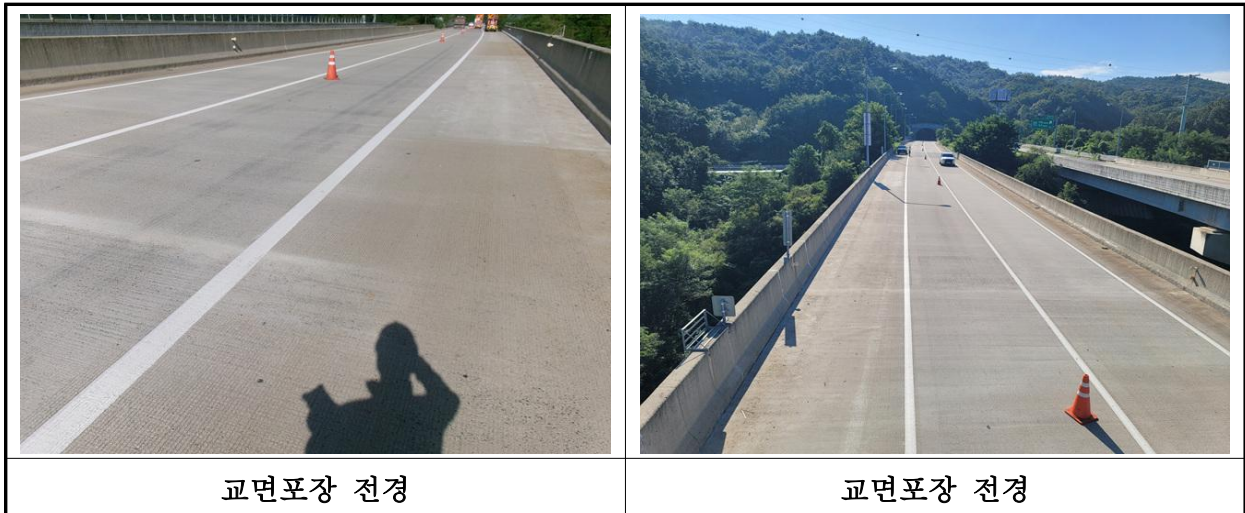
【사진 13.3.20】 교면포장 전경
