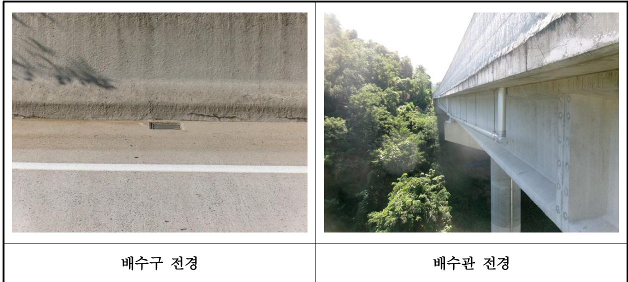
【사진 13.3.22】 배수시설 전경
