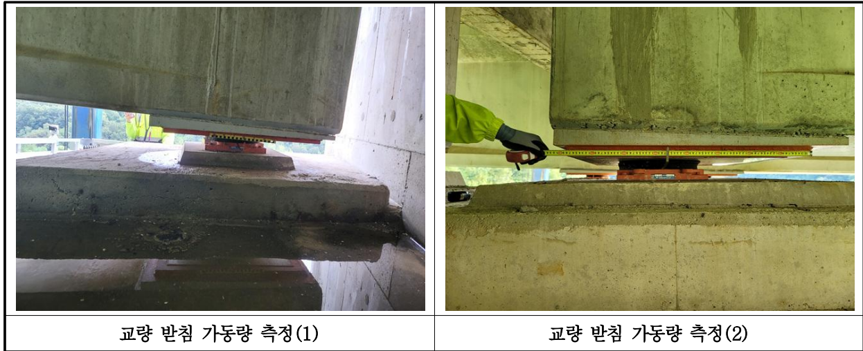
【사진 13.3.41】 교량받침 이동량 측정
