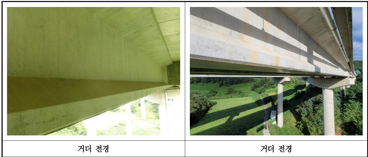
【사진 13.3.29】 거더 전경
