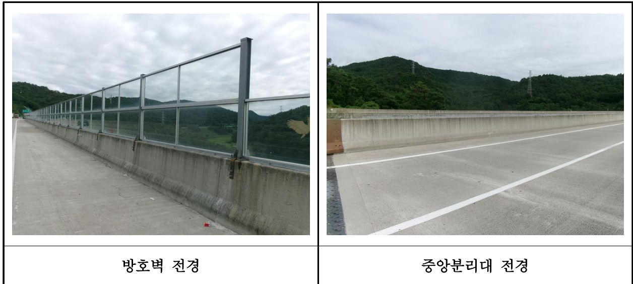
【사진 13.3.49】 방호벽 및 중앙분리대 전경
