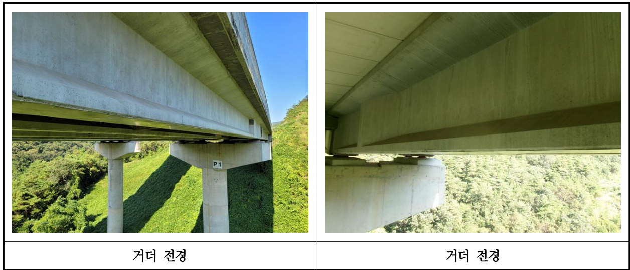
【사진 13.3.4】 거더 전경
